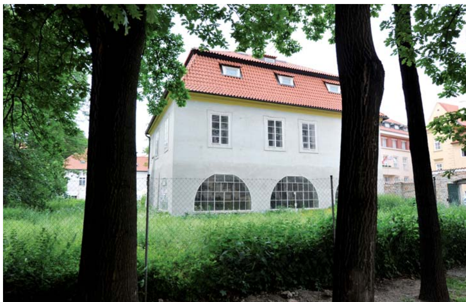
Praha 1 se chystá vilu zrekonstruovat.
