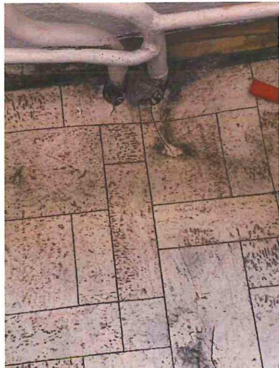
Propadlá špinavá podlaha ve třídě 2.B. Zde chyběly i lišty podél stěn.
