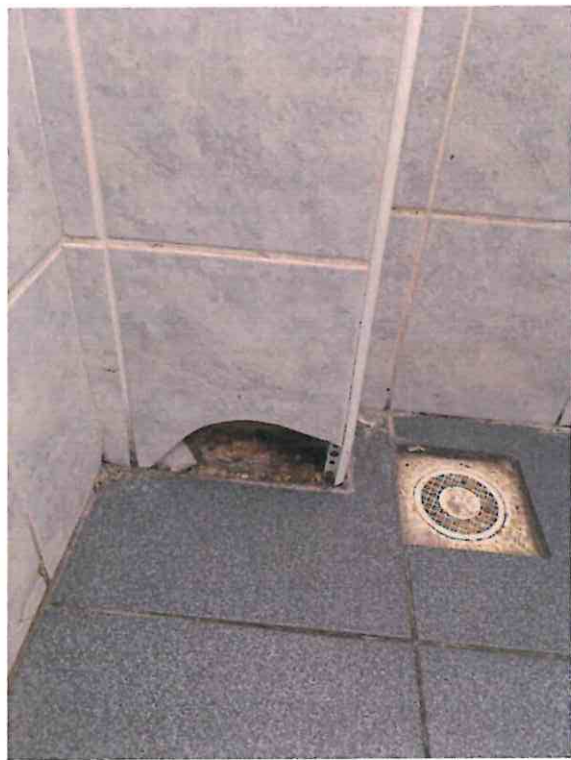
Stav obkladů a odpadních kanálků.
